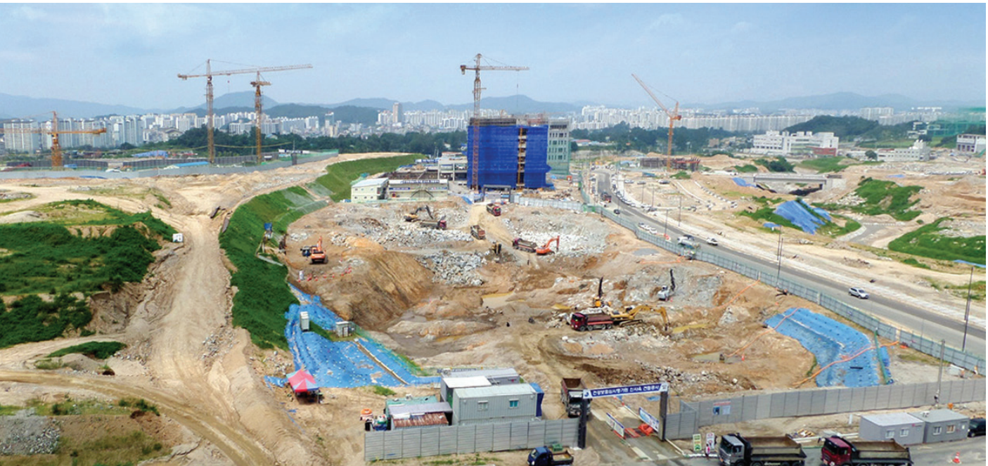
제1신사옥 건설 현장 2013.07
